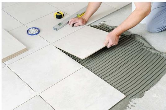
Coloque las piezas sobre el adhesivo presionando mientras mueve la pieza en sentido perpendicular al adhesivo
