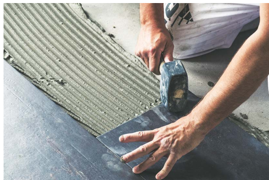
Con un mazo de hule golpee ligeramente las piezas para nivelar y sacar el aire atrapado
